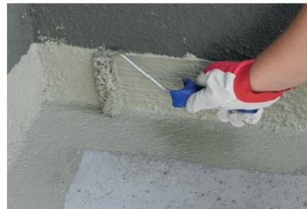
3. Izolácia exponovaných miest: Naniest' náter do kútov a vytiahnuť ho cca 15 – 20 cm od lomu alebo dilatáčnej škáry na každú stranu.
