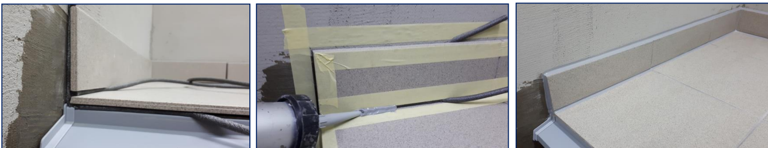
do škár medzi dlažbou a soklom, kútov, rohov a pod dlažbu vložte PE povrazec a škáry vytmelíte PU tmelom
