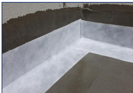
nalepiť pásku na balkónový profil a po obvodu všetkých rohov a kútov
