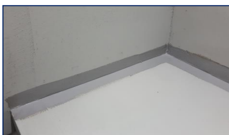
prvý náter hydroizolácie
