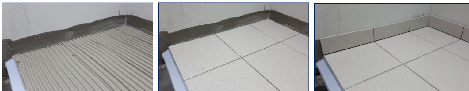
na vyzretú hydroizoláciu naniešť lepidlo zubovým hladidlom, uložiť dlažbu a prilepiť sokel
