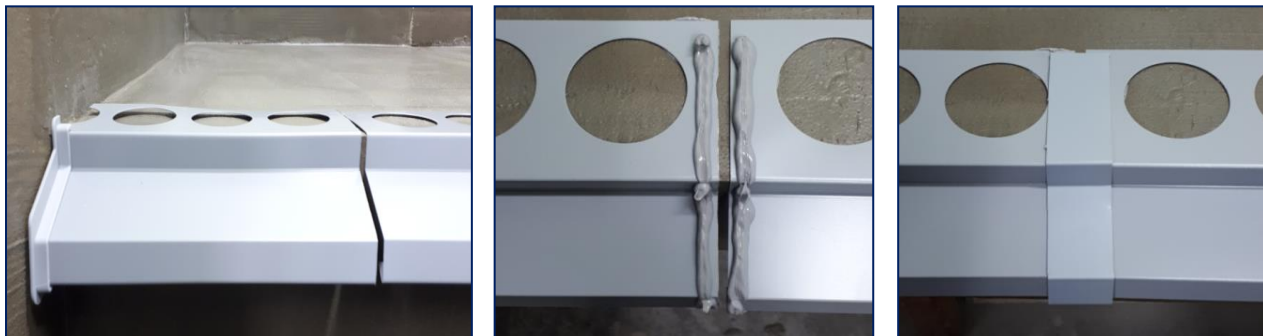
osadiť balkónový profil na vyzretú hydroizoláciu, medzeru medzi dvoma profilmi spojiť spojkou
