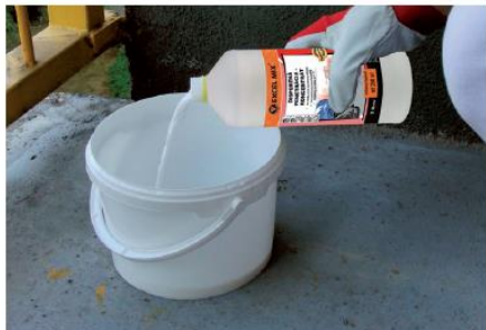
1. Príprava podkladu: Zbaviť podklad prachu, nesúdržných častíc a zjednotiť jeho savosť penetračným náterom.
