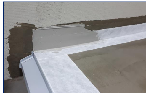
naniest' druhú vrstvu hydroizolácie
