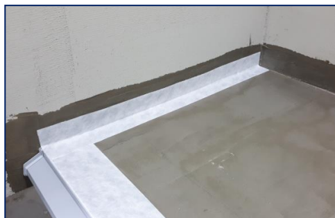
nalepiť pásku na balkónový profil a po obvodu všetkých rohov a kútov
