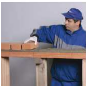
50. Murovanie tlačenej oblasti
