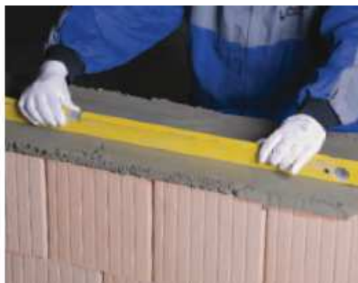
4. Murovacou maltou vytvorená vrstva
