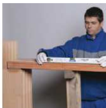
49. Kontrola vodorovnej polohy
