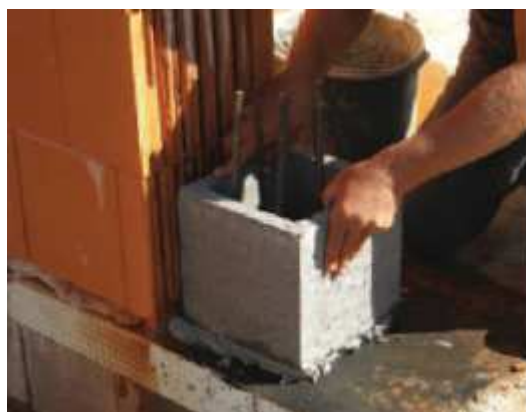
9. Umiestnenie prvej debniacej tvárnice
