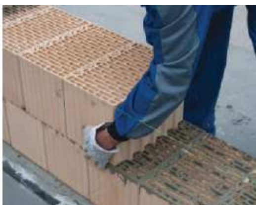
11. Murovanie pri šnúre
