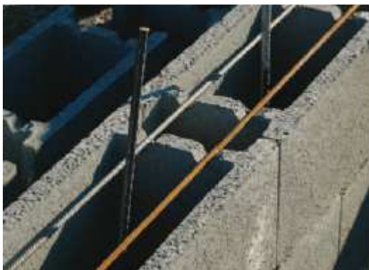
7. Zvislé a vodorovné armovanie pred betónovaním
