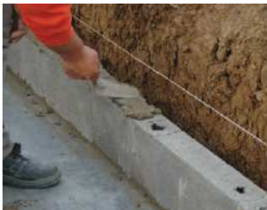
3. Nanesenie maltovej vrstvy
