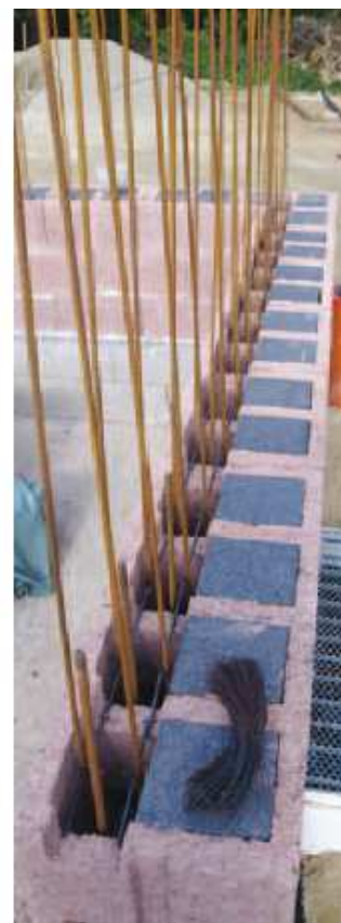
11. Stavba stien Durisol pomocou výstuží
