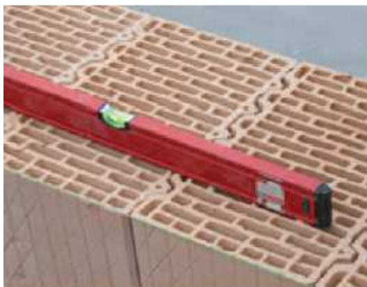
17. Kontrola steny vodováhou
