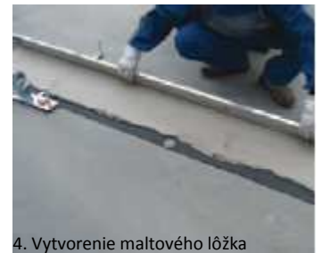
4. Vytvorenie maltového lôžka nivelačnou sadou pod prvým radom
