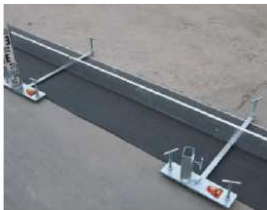
7. Lata položená na nivelačnú sadu
