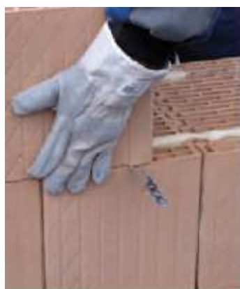
20. Umiestnenie tvárnice pri spojení stenovej spony
