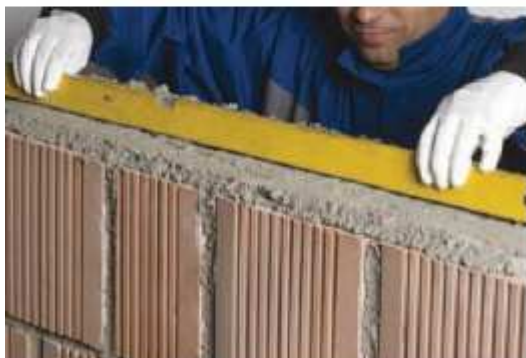
38. Stavba protihlukovej steny: vytvorenie
