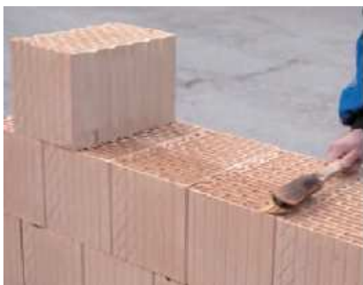
13. Navlhčenie murovacieho prvku LeierPLAN pred lepením
