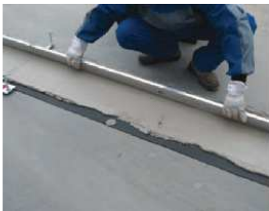
8. Vytvorenie maltového pásu pod prvým radom
