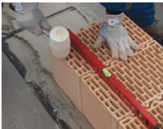
9. Vyloženie prvého radu
