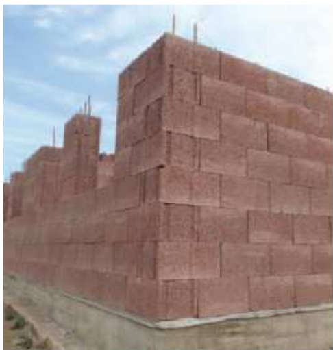
1. Stena Durisol vybudovaná na železobetónovú podmurovku
