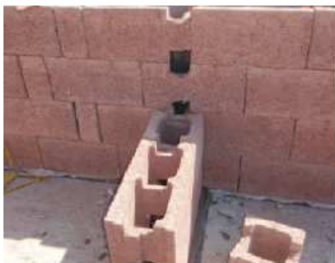
7. Spojenie steny
