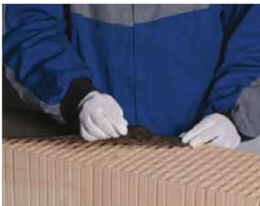
18. Uzavretie konštrukcie steny bitúmenovou izolačnou doskou
