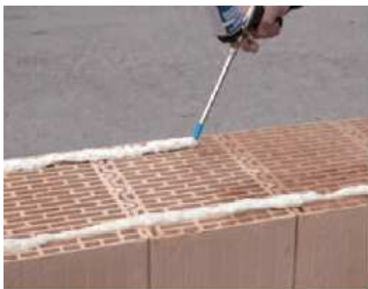
15. Nanesenie univerzálneho lepidla LeierFIX 5 – 6 cm od okrajov
