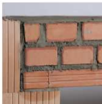
52. Vytvorenie hornej roviny pri stene LeierPLAN
