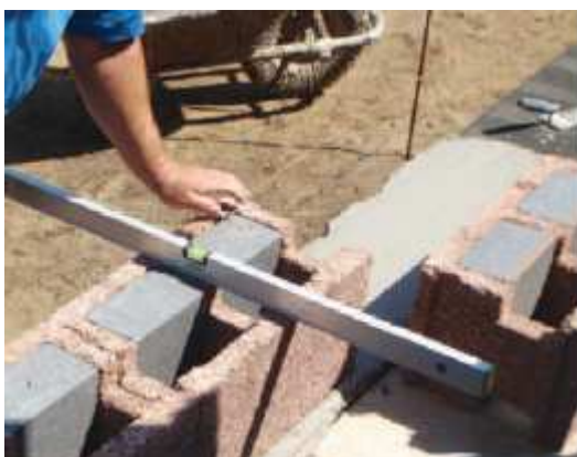
5. Murovanie prvého radu
