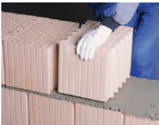
3. Vloženie murovacieho prvku do maltového lôžka
