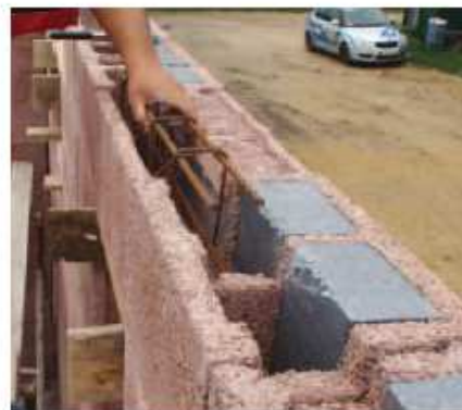
22. Vloženie výstuží do prekladov
