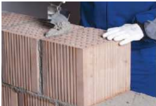
36. Protihluková stena zvislá medzera
