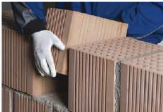
37. Umiestnenie rezaného prvku do protihlukovej steny
