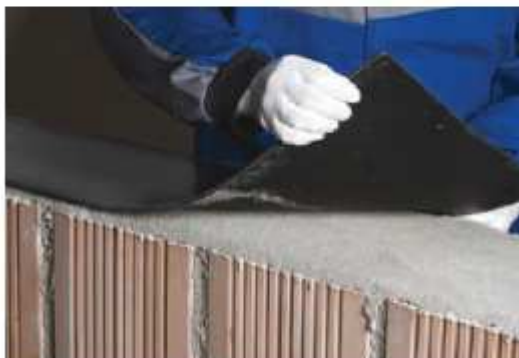
39. Flexibilná podložka na vyrovnávacej vrstve
