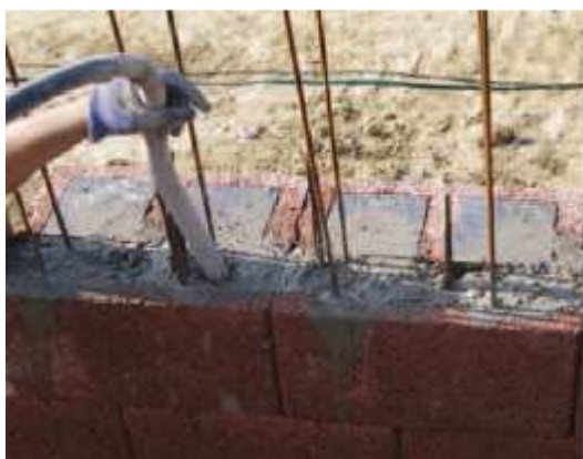
16. Zhutnenie zapracovaného betónu
