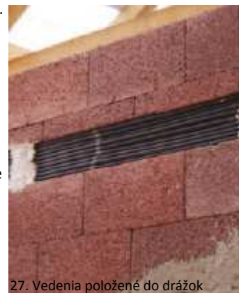
27. Vedenia položené do drážok
