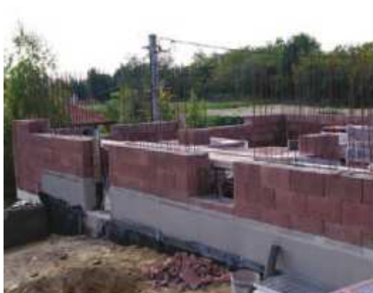
14. Stavba steny betónovanej po úsekoch
