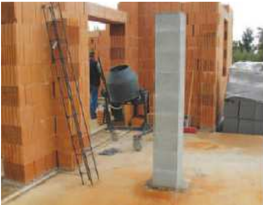
11. Stĺpové debnenie a vystuženie
