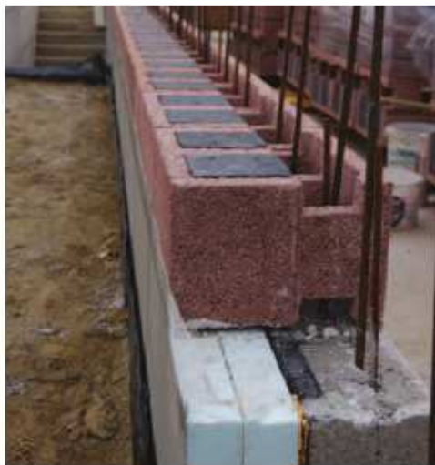
2. Stena Durisol vybudovaná na podmurovku z tvárnic Leier (spojovacou výstužou)
