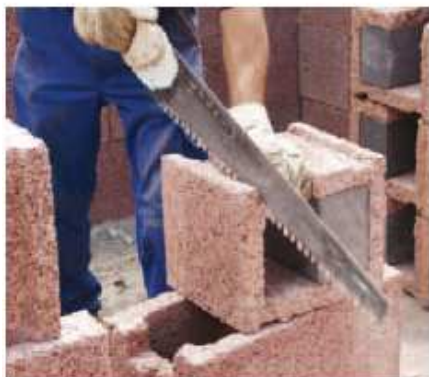
20. Vyrezanie drážok tvárnic zabudovateľnej do prekladu
